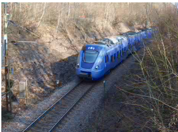
Figur 7. Befintlig järnväg passerar Pålsjö skog i en ravinliknande skärning.
