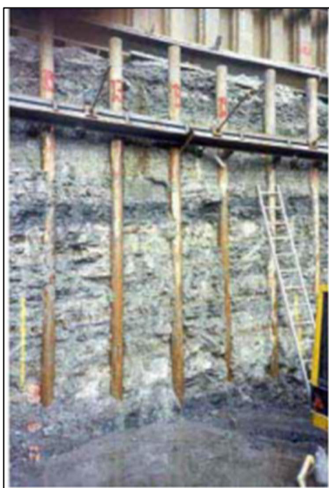
Figur 29. Omfattande temporär förstärkning vid utbyggnaden av tågtunnlar i Helsingborg – början av 1990-talet. Källa: WSP, presentation- Workshop Helsingborg-Helsingör: Conceptual design of tunnels and underground (sida 38), 2019-02-26
